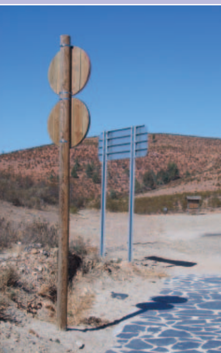
Revestimiento con madera para reducir el impacto visual.
